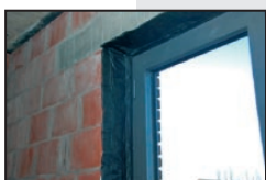
plaatsing met vouwfolie
